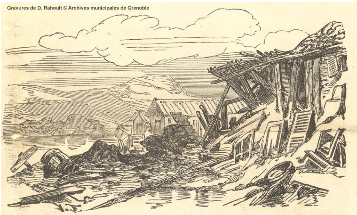
Maison effondrée lors de l'inondation du 2 novembre 1859 La maison des Tripiers, sur le chemin qui mène au Polygone, le long de l'Isère, à peu de distance de l'Abattoir. Cette maison était construite en Pisé. Elle s'écroula le 2 novembre 1859 après midi (Gravures sur bois de Diodore Rahoult © Archives municipales de Grenoble).
